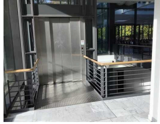
Weg innen – vom Eingang zum Lastenaufzug
