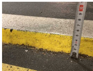
Weg innen Parkplatz zum Aufzug
