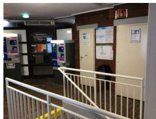
Aufzug im Parkhaus
